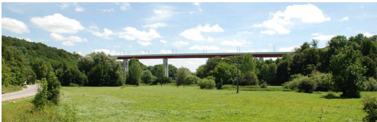
Franchissement de la vallée de la Lizaine (LGV Rhin-Rhône), avec conservation d'un grand nombre d'arbres existants
