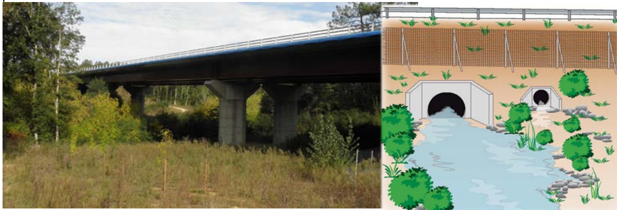
Ouvrages de franchissement de type 1 : viaduc (à gauche) et de type 3 : buse avec buse sèche complémentaire pour petite faune terrestre (à droite)
